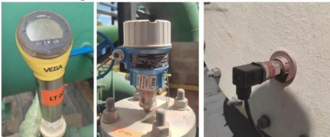
Imagem 3: Medidor Hidrostático de nível do reservatório.
