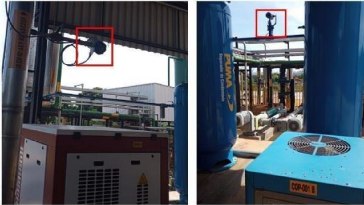
Imagem 3: Medidor Hidrostático de nível do reservatório.
