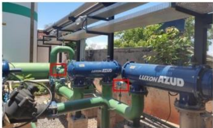
Imagem 3: Medidores de pressão saída do compressor e do soprador.
