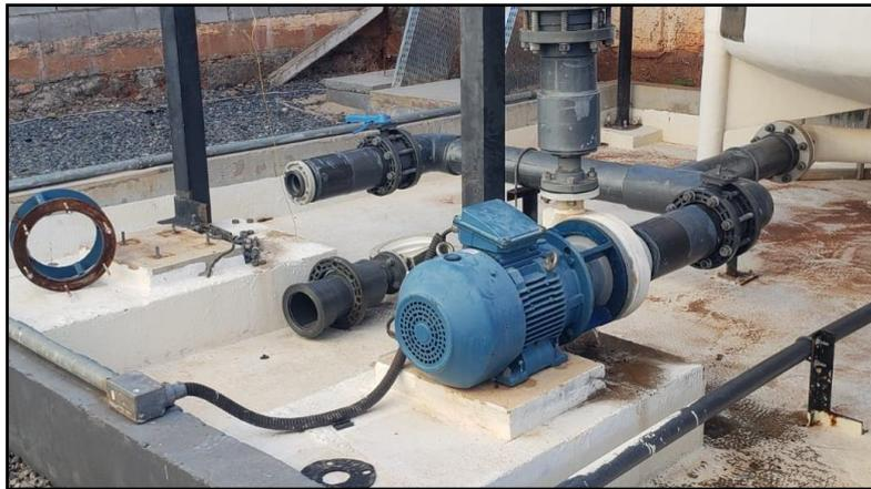
**12.6.** O outro bombeador danificou, pelo uso, o encaixe de ligação entre o rotor e eixo do motor, e não é possível recuperação, sendo necessário a aquisição de um novo.
